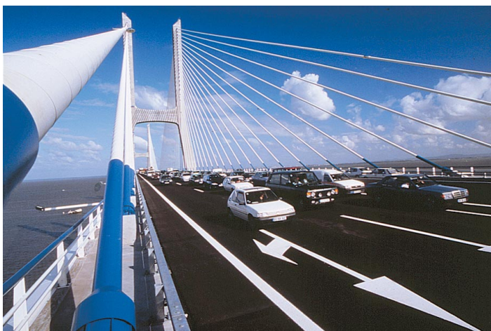
Le pont Vasco de Gama sur le Tage, à Lisbonne. La résistance d'une structure complexe telle qu'un pont peut être contrôlée de façon active en plaçant, en des endroits bien choisis, des dispositifs qui vont, selon les mouvements de la structure, modifier ses caractéristiques mécaniques afin de contrecarrer les effets de résonance. La théorie mathématique du contrôle traite de telles situations. (Cliché Gamma/Gilles Bassignac)
